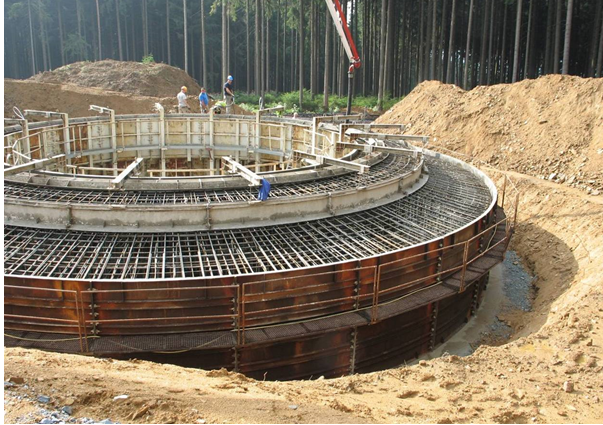
Abb. 1: Fundamentbau für eine WEA (Bildquelle: LfU)
