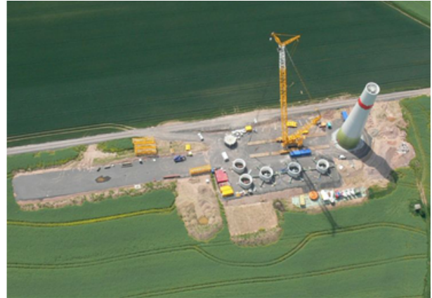
Abb. 2: Baustelle zur Errichtung einer WEA (Bildquelle: Juwi Holding AG)
